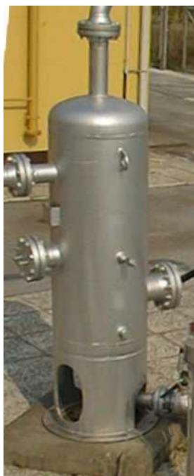
Slika 2: Separator vgrajen na instalaciji
