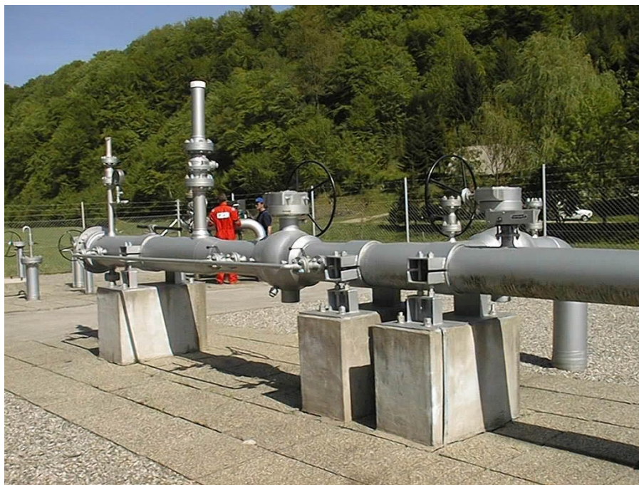
Slika 2: Čistilna komora z obtočnim vodom.
