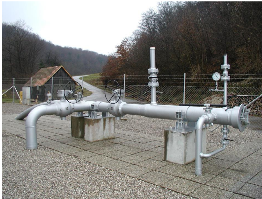
Slika 1: Čistilna komora s priključki
