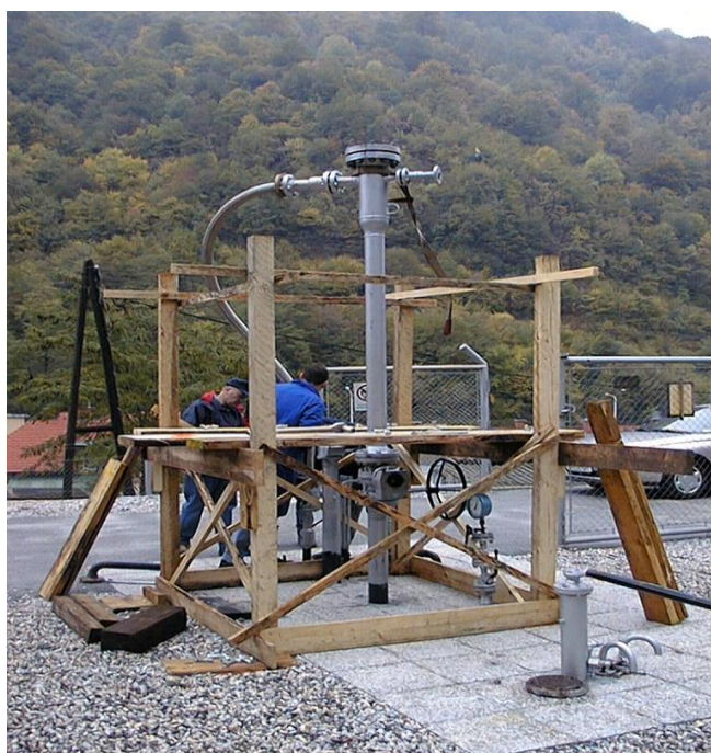
Slika 4: Poenostavljena čistilna komora - vertikalna izvedba.
